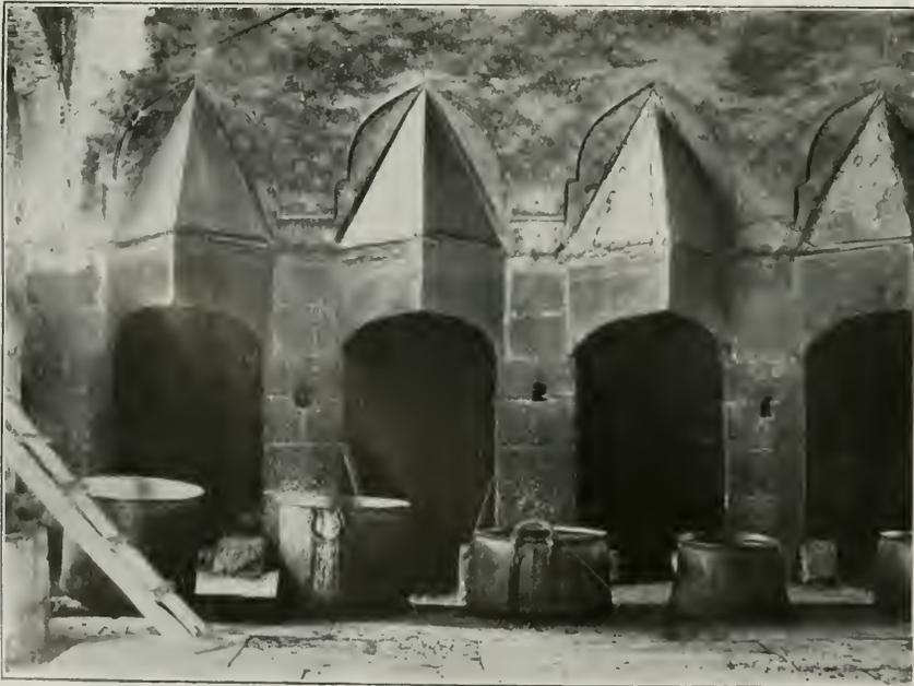
Abb. 37. Öfen und Kessel im Aschevi.
